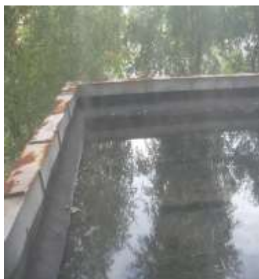
лошо отводняване на покрива
