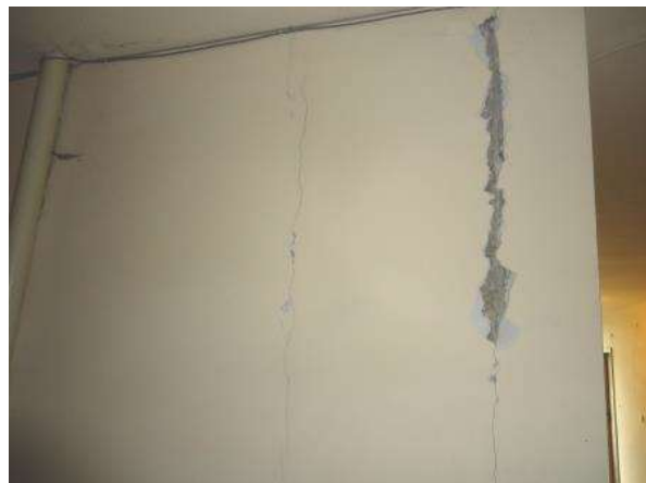
Пукнатини на местата на технологично прекъсване на стоманобетоновите елементи /стени в стълбищната клетка/
