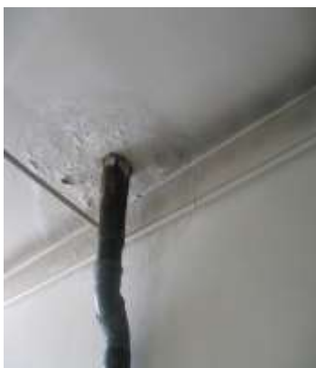
ВКК за дъждовни води теч по покривната плоча
