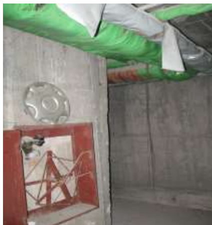
Хоризонтална мрежа в сутурена топлоизолирана и ПК 2"
