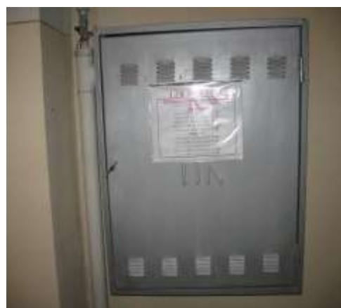
Сградна противопожарна инсталация Противопожарно табло
