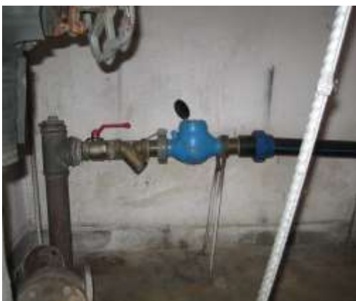
Сградно водопроводно отклонение Водомерен възел
