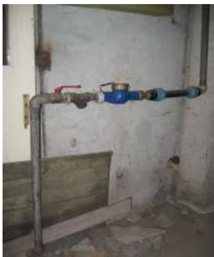
Сградно водопроводно отклонение
